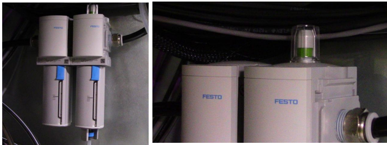
Рисунок 2-28: Сборка фильтров, слева; Индикатор состояния фильтра - справа
