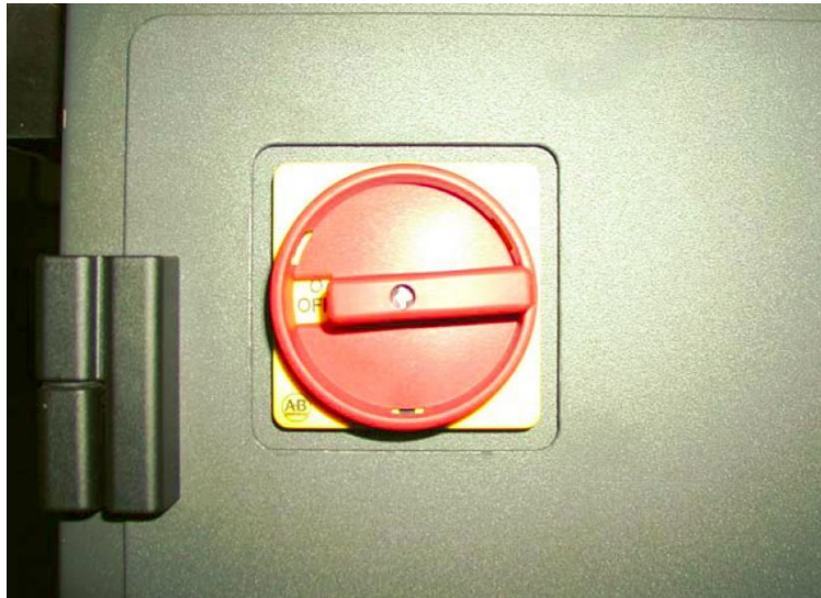
Основной отключающий переключатель в позиции Off
