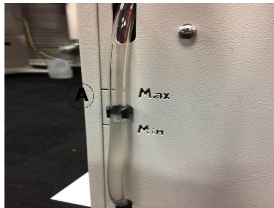
Рисунок 7-15: Уровень жидкости в чиллере
