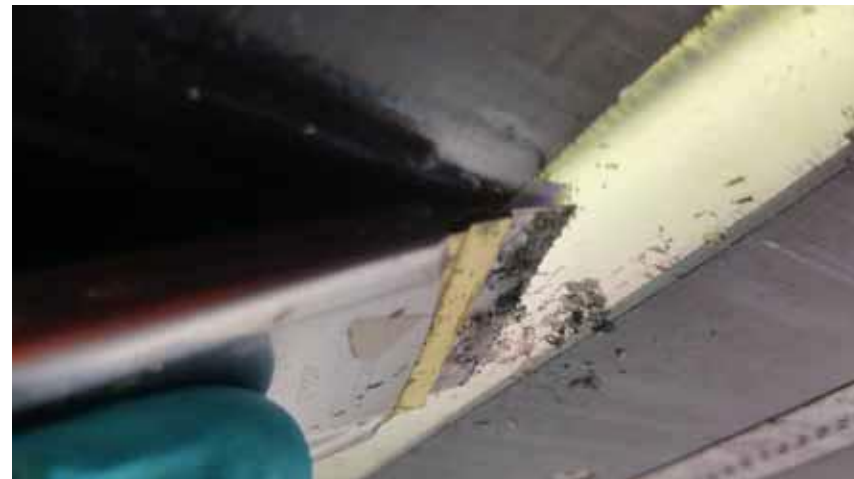
Рисунок 2-22: Чистка стекла LED-лампы лезвием
