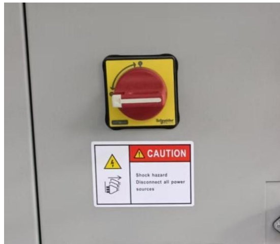
Рис. 2: Главный выключатель
